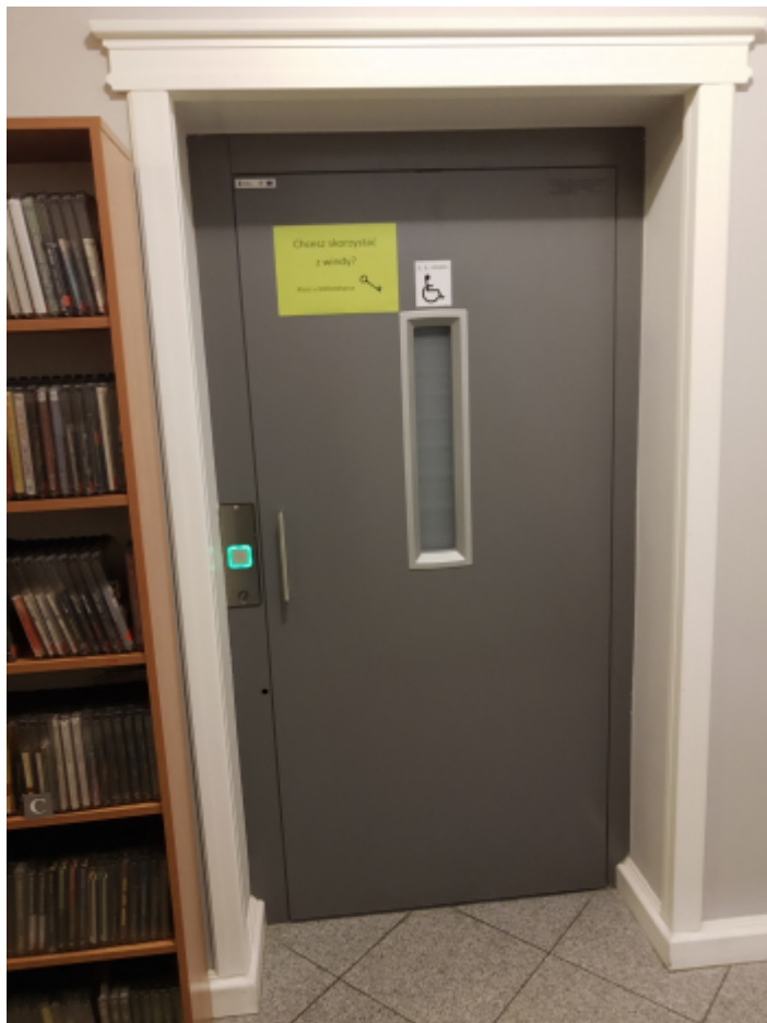
Platforma dla osób ze szczególnymi potrzebami
