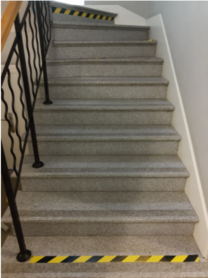
Oznaczone klatki schodowe
